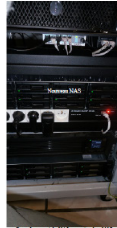
Remplacement du NAS en septembre 2017
